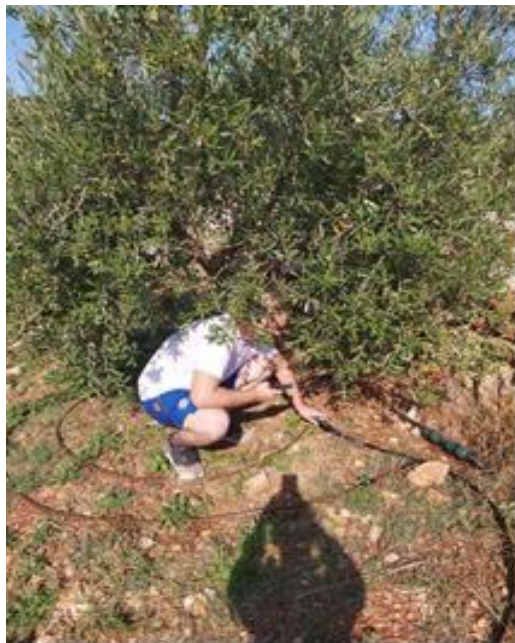
Slika 1. Postavljanje sustava za navodnjavanje (Izvor: Marčelić Š., arhiva projekta SAN, 2019.)
