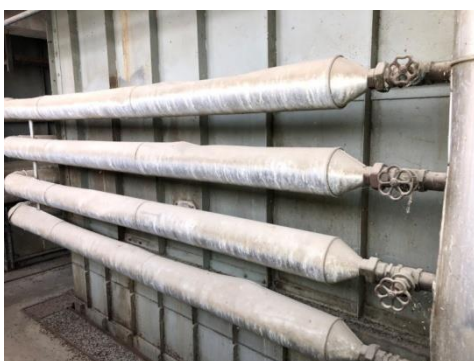
Slika 28. Parovod (Izvor: slikao autor)
