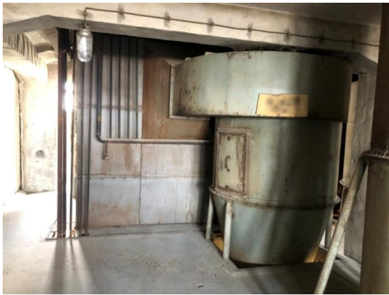
Slika 30. Zaustava za nečistoće
