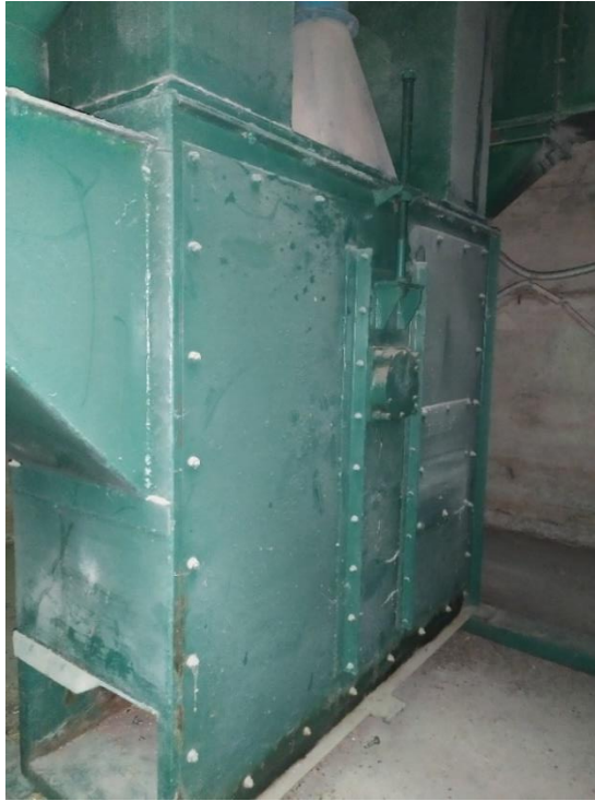
Slika 9. Podnožje elevatora Kovinar
