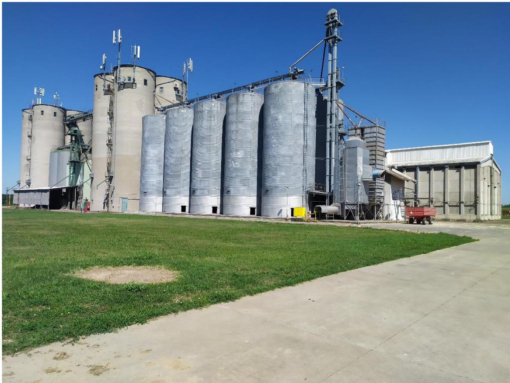
Slika 1. Silos „PZ Jankovci“ (Izvor: Vlastita fotografija)
