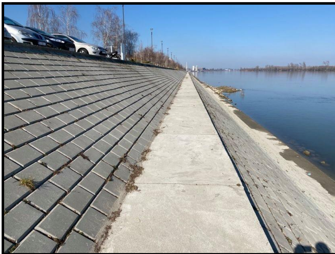
Slika 3. Obaloutvrda uz šetnicu u Vukovaru – novija gradnja
