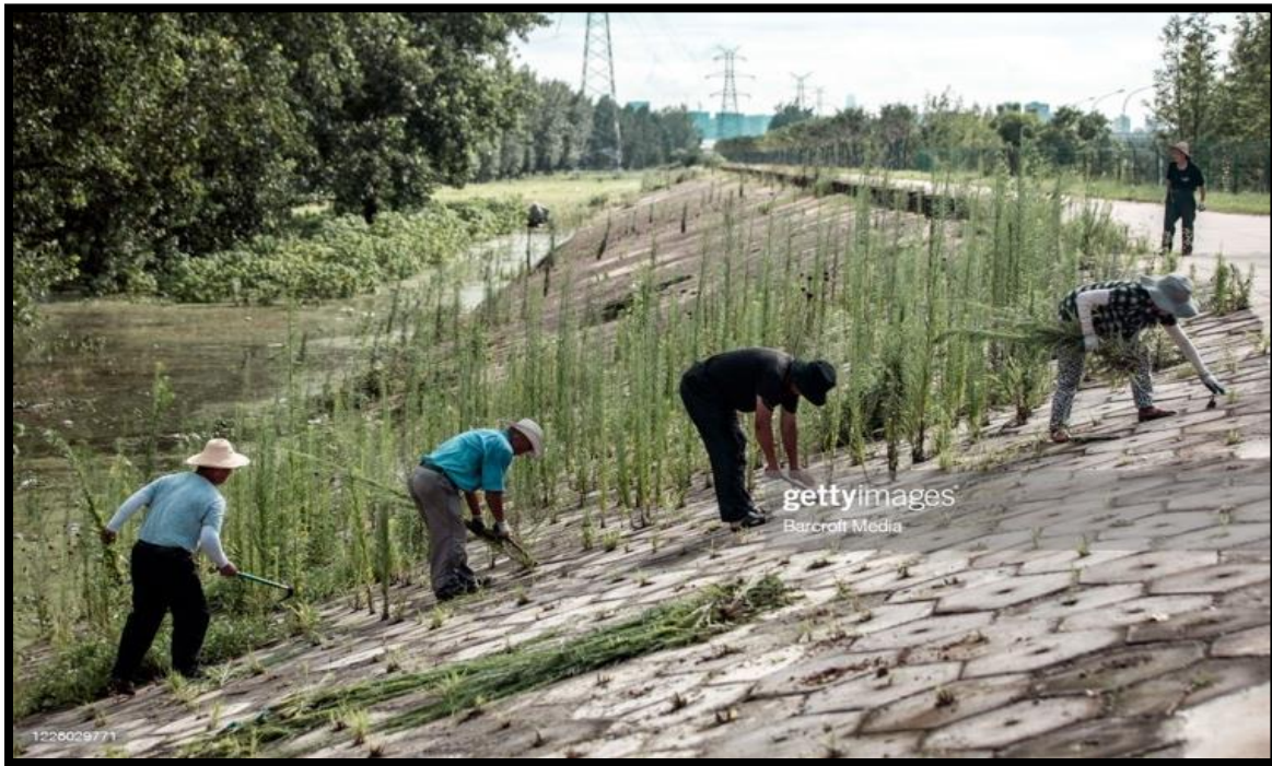
Slika 1. čišćenje zaraslih obalo-utvrda od korova
