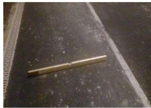
Slika 14) provjera kuta građevinskom labelom 600 mm na istoj stazi
