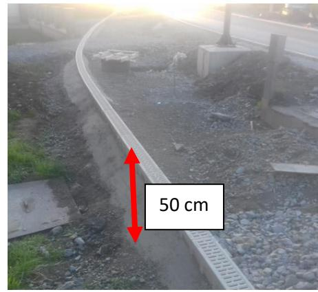
Sl.11) Izvedba kanalice koja je 50 cm viša od šahta u susjednom dvorištu.
