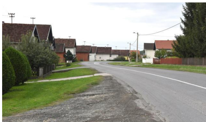
Slika br. 3 Stanje u Ulici kralja Zvonimira prije rekonstrukcije i vidljivi nagib od razine ceste na desnoj strani u Ulici kralja Zvonimira (Izvor: Glas Slavonije, 16.10.2015.)
