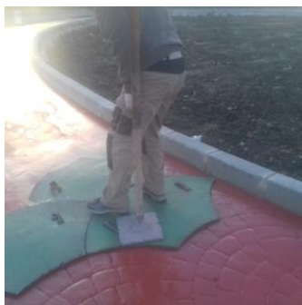
Sl. 27) Izvođenje ruba zelene površine unutar kružnog toka (Izvor: Autor, 2021.)
