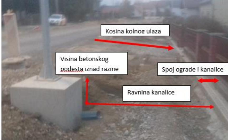
Slika 8) Betonski stupovi za rasvjetna tijela koji nisu postavljeni na način da ih zelena površina skriva, tj.
