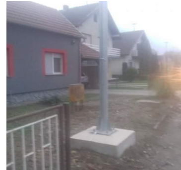
17) Kuća sa slike 16 nakon uklanjanja stabala i postavljanja rasvjete (Izvor: Autor, 2021.)
