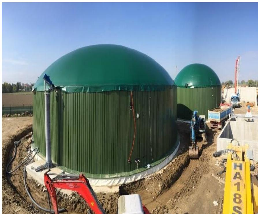
Slika 2. Izrada anaerobnih digestora od nehrđajućeg čelika
