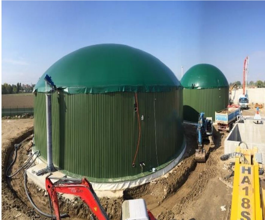
Slika 2. Izrada anaerobnih digestora od nehrđajućeg čelika
