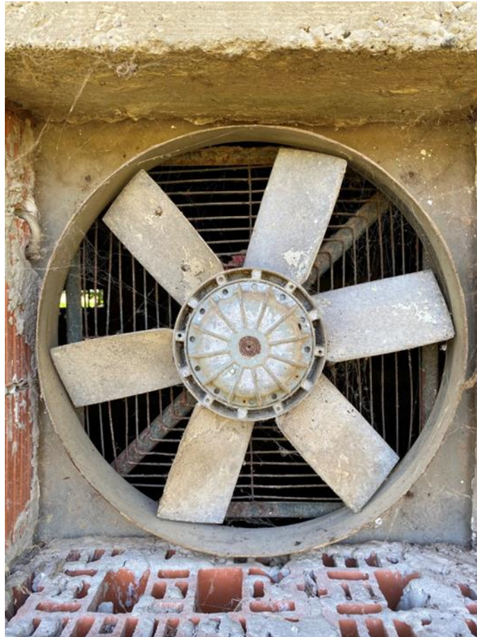
Slika 15. Aksijalni ravni ventilator Izvor: Vlastiti izvor (Hamm)
