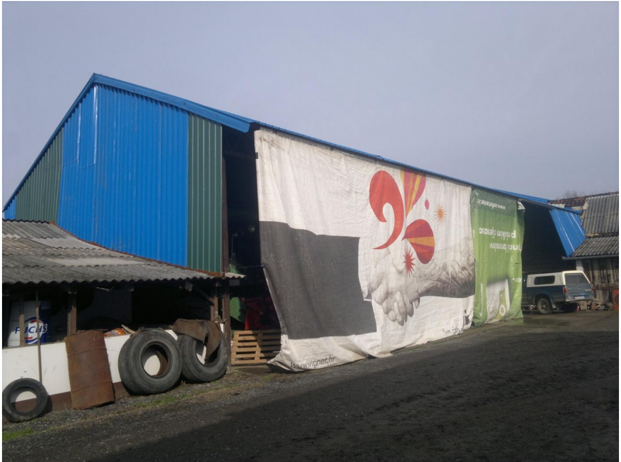
Slika 5. Nadstrešnica zatvorena sa ceradom
