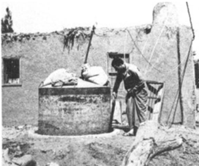
Slika 5. Preteća bioplinskog postrojenja Indija
