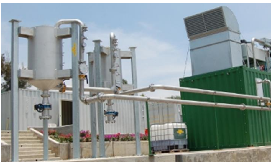
Slika 33. Spremnik i filter aktivnog ugljena
