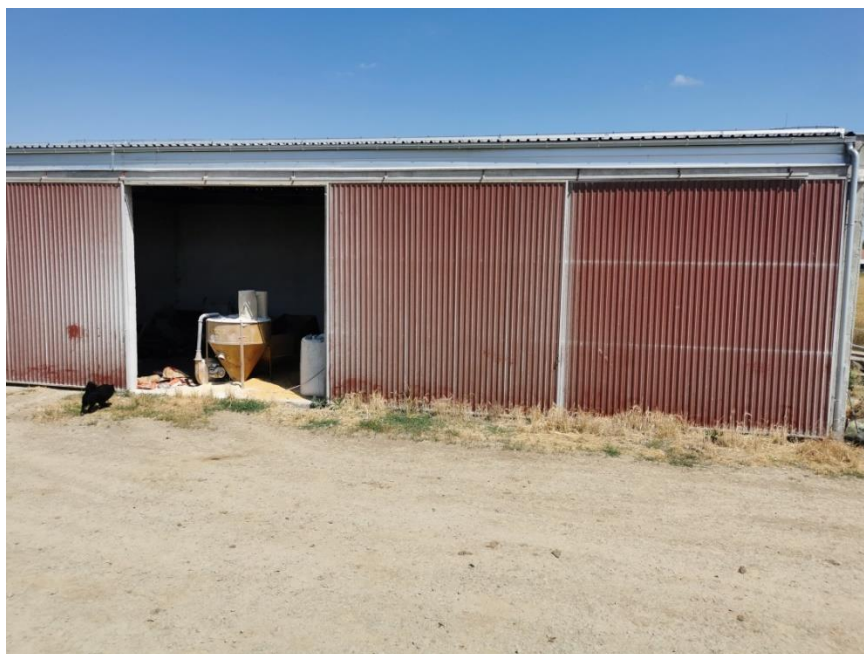
Slika 4. Podno skladište za hranu
