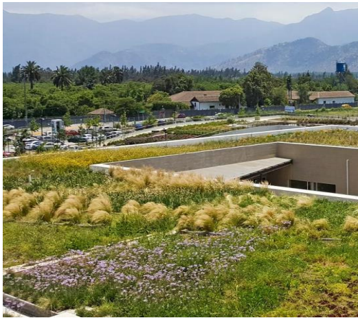
Sl. 30. Ekstenzivni zeleni krovni vrt u gradu
