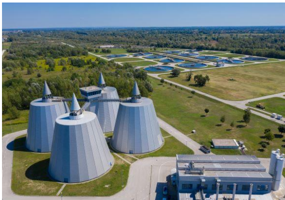
Sl. 28. Objekti za pročišćavanje otpadnih voda grada Zagreba
