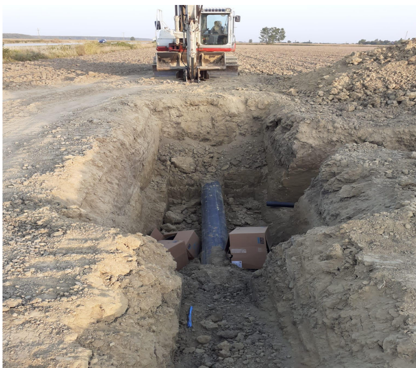
Slika 4. Ugradnja podzemnih dovodnih cijevi
