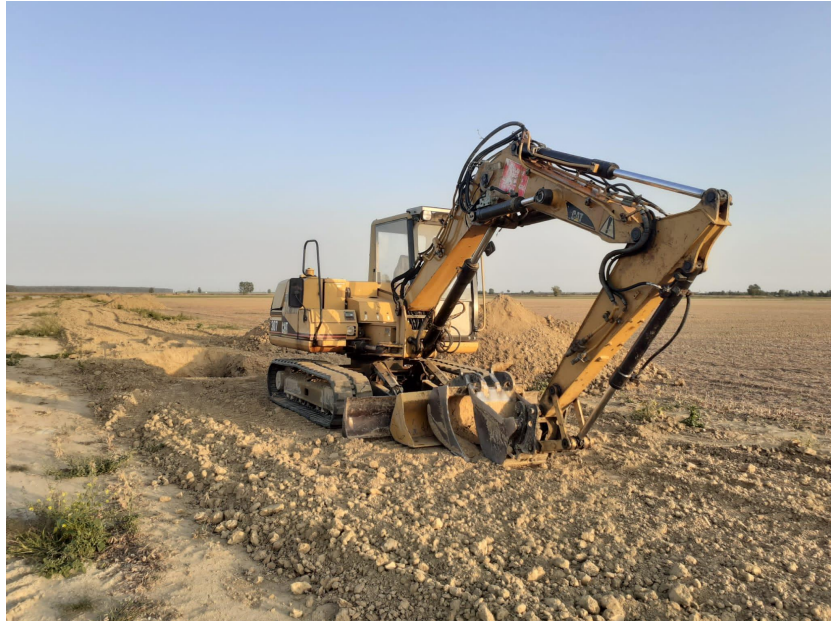
Slika 5. Radovi na razvođenju vode za potrebe navodnjavanja (Foto: Marinčić, 15.09.2021.)
