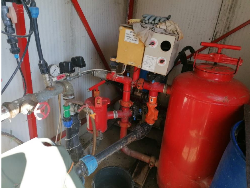
Slika 17. Sustav za navodnjavanje i fertirigaciju izvor: Škoro, 2020.
