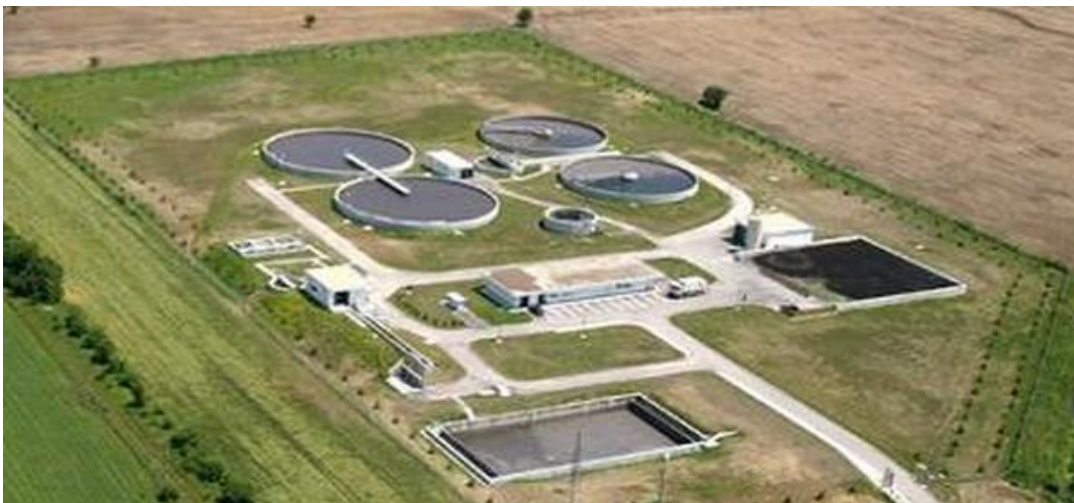
Slika 39. Industrijska zona Jošine – pročišćivači vode Izvor: https://www.elmap.hr/hr/reference
