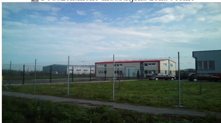
Slika 18. Izgradnja velikih objekata industrijske zone Jošine Izvor: http://investcroatia.gov.hr/en/zone/proizvodno-industrijska-zona-josine
