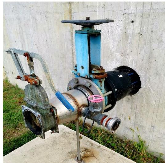
Slika 24. Ventil za ispuštanje tekuće frakcije digestata
