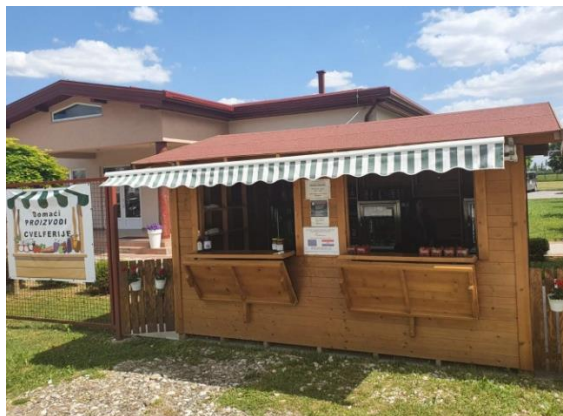
Slika 4 Drvena kućica ispred PPID
