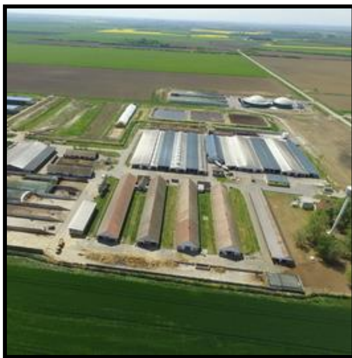
Slika 4. Bioplinsko postrojenje Orlovnjak
