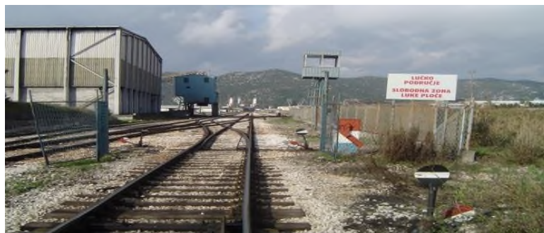
Slika 32. Industrijski kolosijek – Luka Ploče
