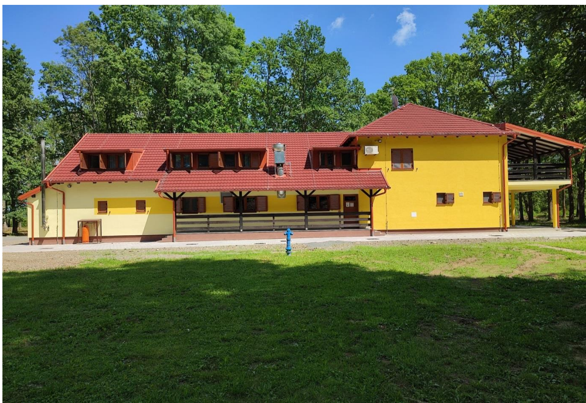
Slika 7. Lovačka kuća "Radinje"
