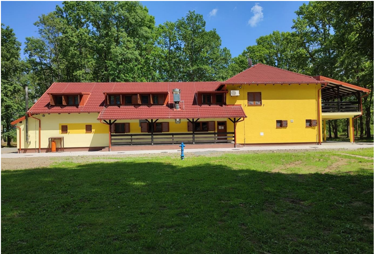
Slika 7. Lovačka kuća "Radinje"
