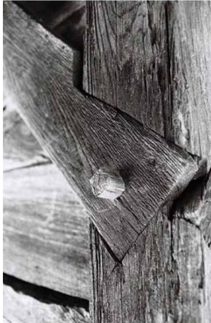
Slika 12. Spojnice od elemenata drva, bez metalnih spojeva i čavli Izvor: Živković, 2013.
