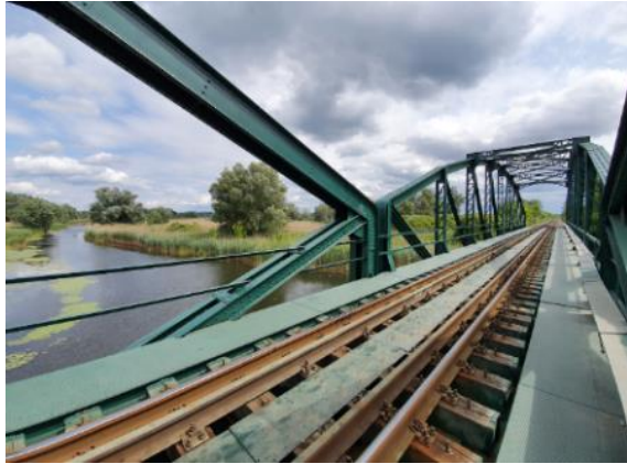
Slika 6. Željeznički most preko Stare Drave (Foto: S. Ozimec)
