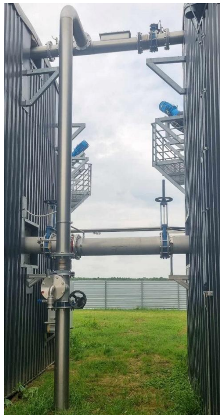
Slika 14. Preljevna cijev
