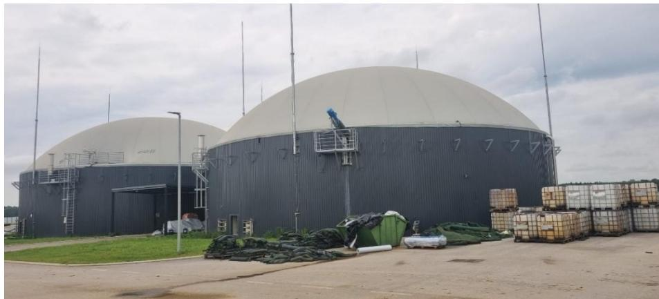
Slika 8. Digestor i postdigestor
