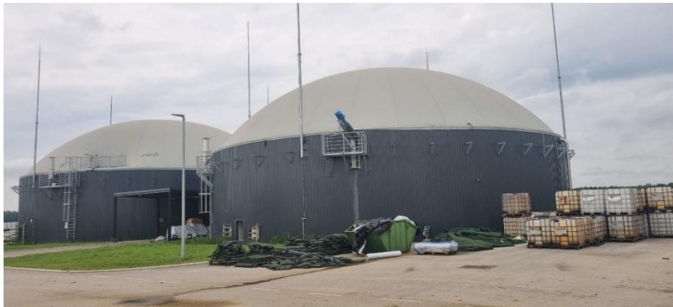
Slika 8. Digestor i postdigestor
