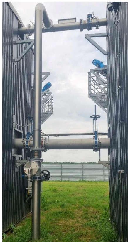
Slika 14. Preljevna cijev
