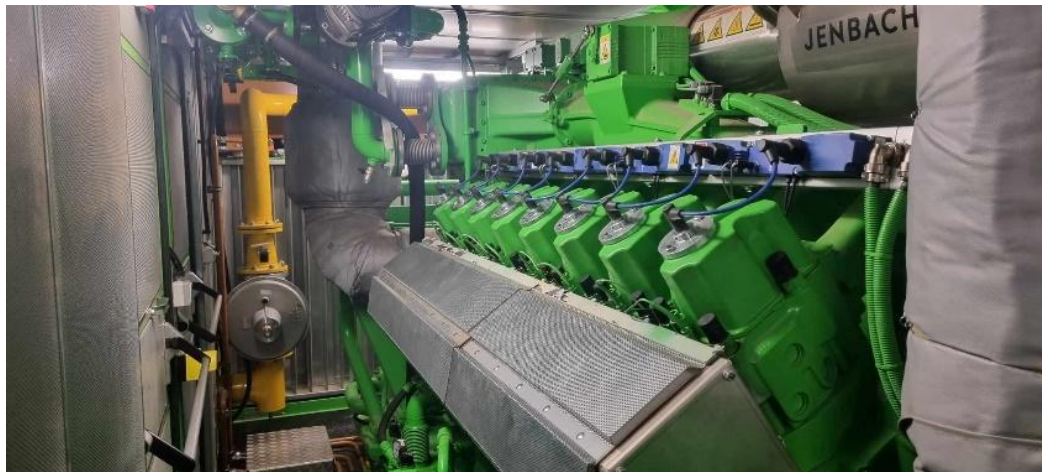
Slika 21. Bioplinski motor (Izvor: vlastita fotografija)
