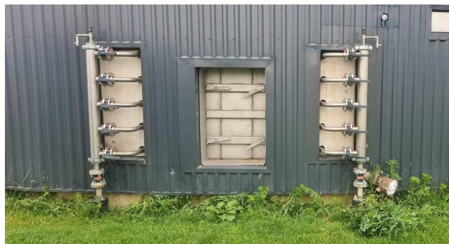
Slika 13. Cijevi za odvod i dovod topline u digestor
