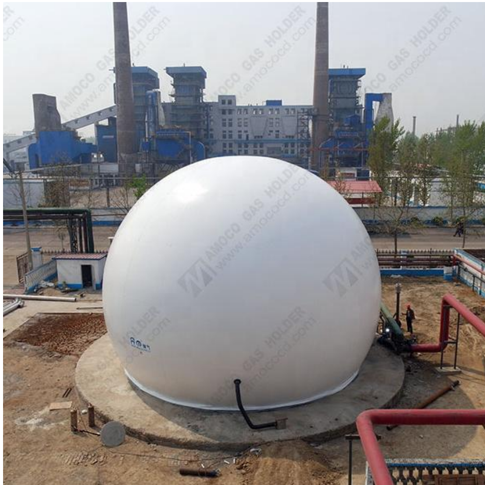
Slika 10. Spremnik bioplina
