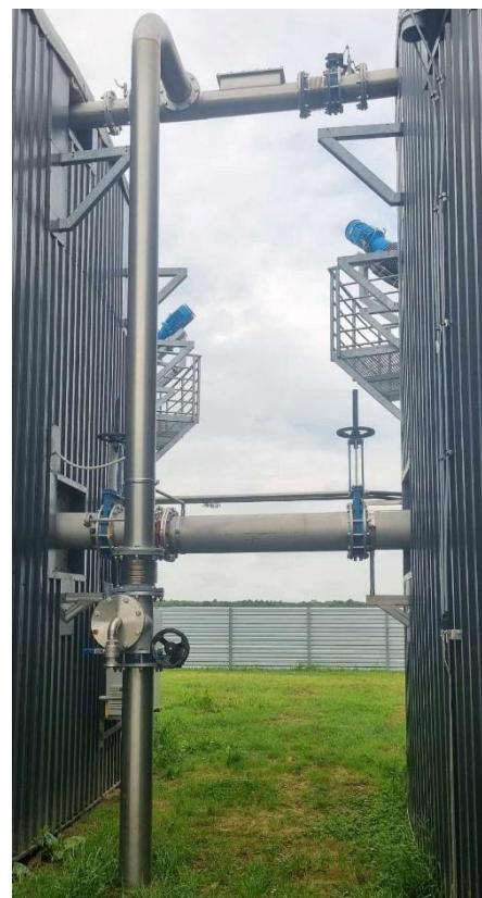
Slika 14. Preljevna cijev
