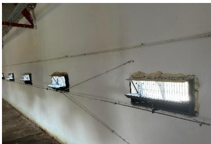
Sl. 11. Sustav za rashlađivanje objekta (Izvor: Mislav Bilen)
