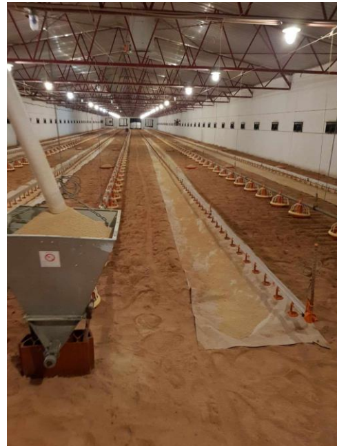
Sl. 17. Pripremljen objekt za tov
