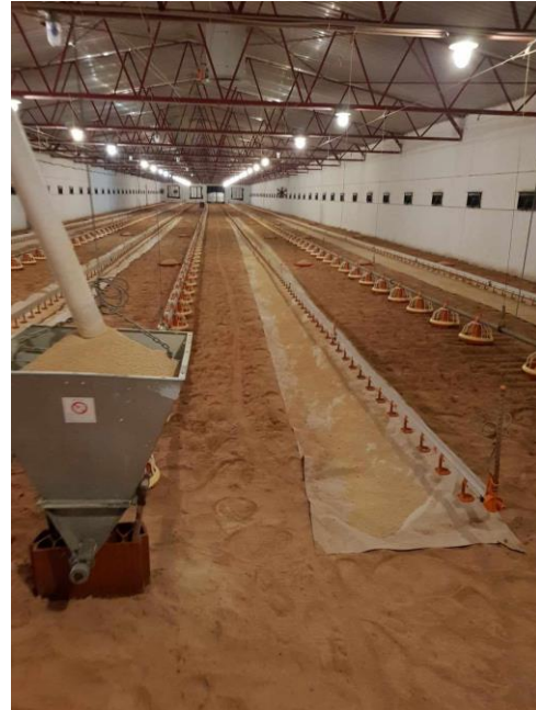
Sl. 17. Pripremljen objekt za tov
