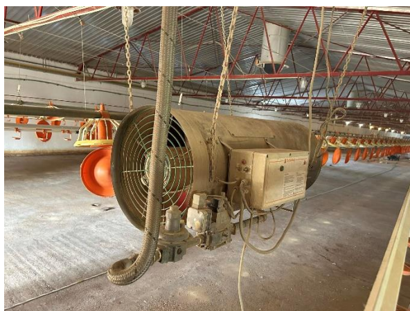
Sl. 7. Sustav za zagrijavanje objekta
