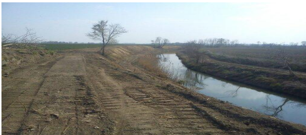
Slika 3. Radovi na uređenju korita Karašice, u travnju 2014. (Foto: Ivan Mandić)
