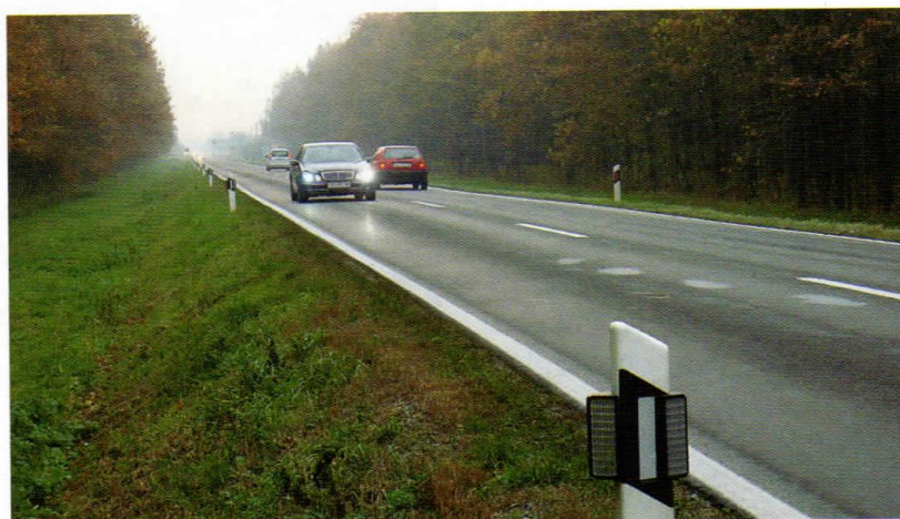
Slika 9. Optički reflektori na smjerokaznim stupićima postavljeni uz državnu cestu D2 između Kalinovca i Budančevice u Podravini (Izvor: Janči, 2010.).
