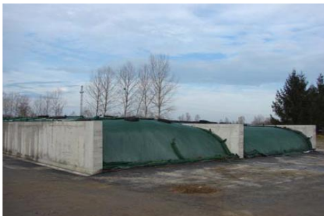
Slika 12. Pravilno izgrađeni silosi sprječavaju cijeđenje silažnog soka u vodotoke (Katalinić i sur., 2009.)
