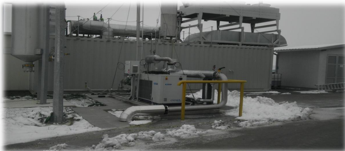
Slika 3. CHP- jedinica
