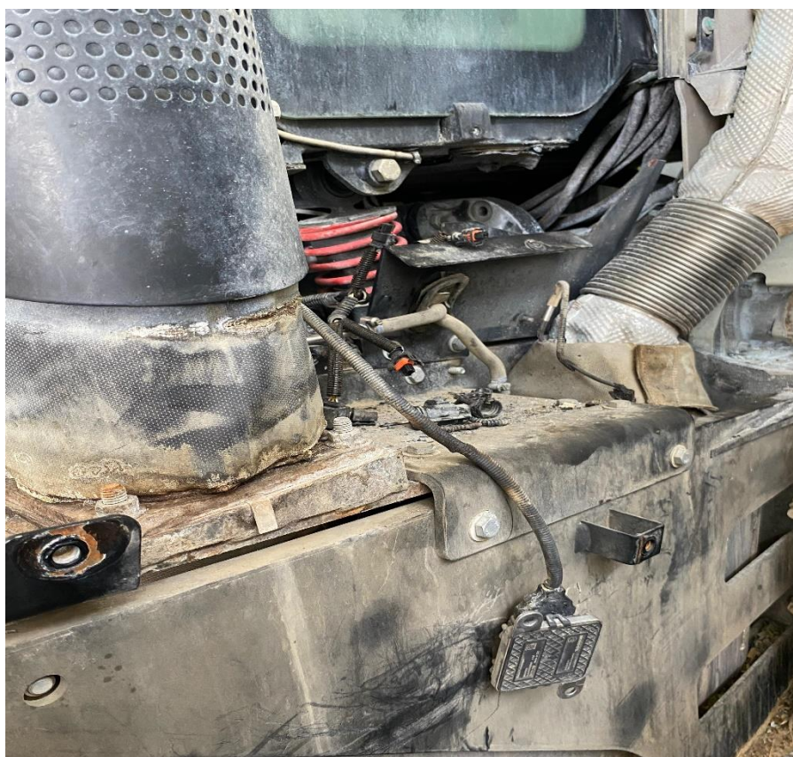
Slika 8. Zapaljenje električne instalacije
