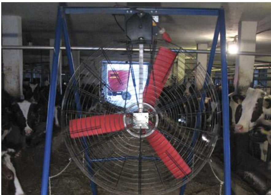
Slika 3. Mehaničko prozračivanje staje s ventilatorom (izvor: http://www.sano.hr/Sano-ventilator )
