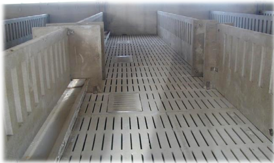
Slika 5. Primjer rešetkastog poda u objektu za držanje svinja (Izvor: http://www.jodito-f.si/ponudba/prasicjereja/podnozje-svinjaka-jama )
