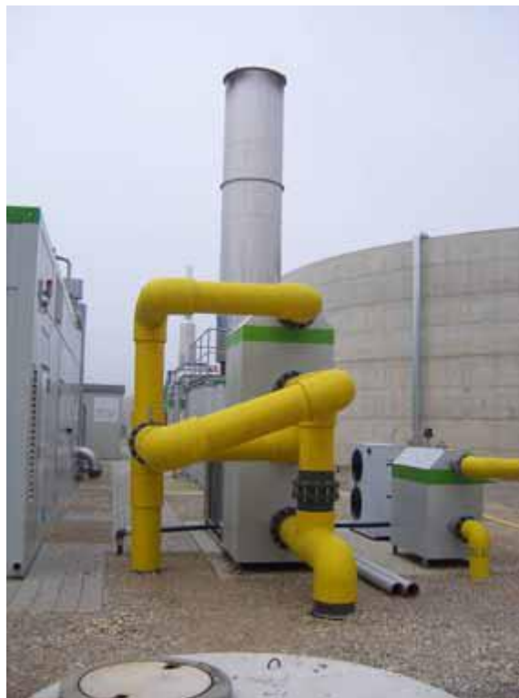
Slika 25. Moderne baklje za bioplin
