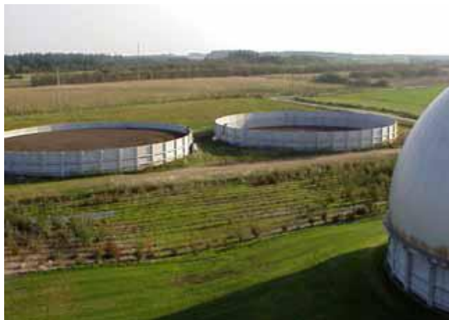
Slika 26. Spremišta za skladištenje digestata pokrivena prirodnim plutajućim slojem.
