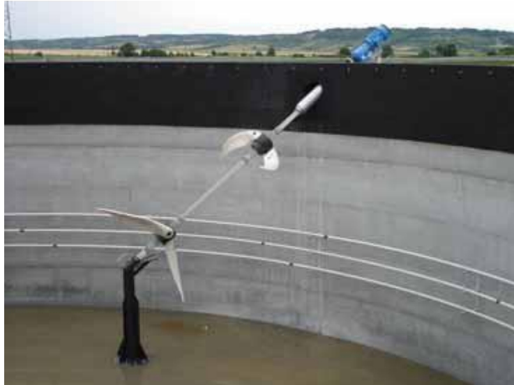
Slika 22. Miješalica s lopaticama smješšana unutar fermentatora.
