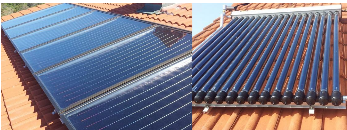
Slika 4. : Pločasti i vakuumski solarni kolektor
