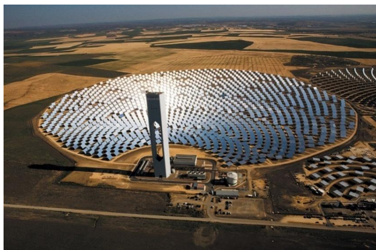
Slika 7. : STE sa tornjem u Španjolskoj snage 11 MW
