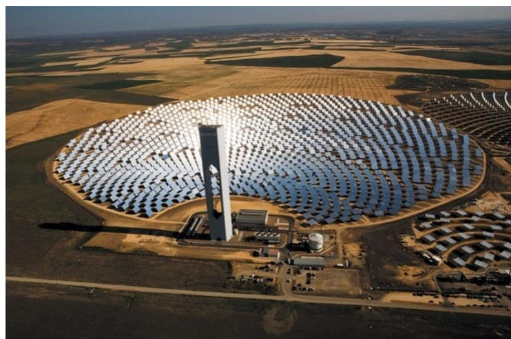
Slika 7. : STE sa tornjem u Španjolskoj snage 11 MW
