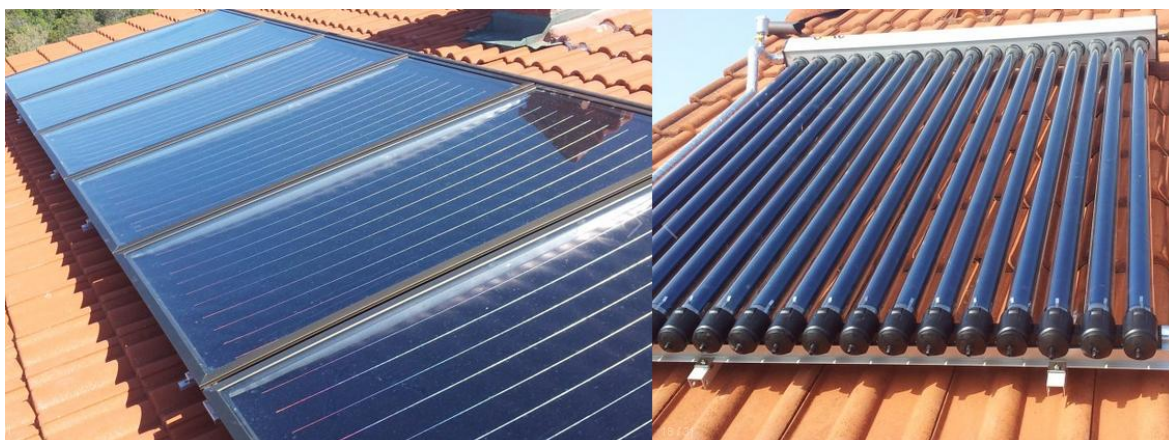
Slika 4. : Pločasti i vakuumski solarni kolektor
