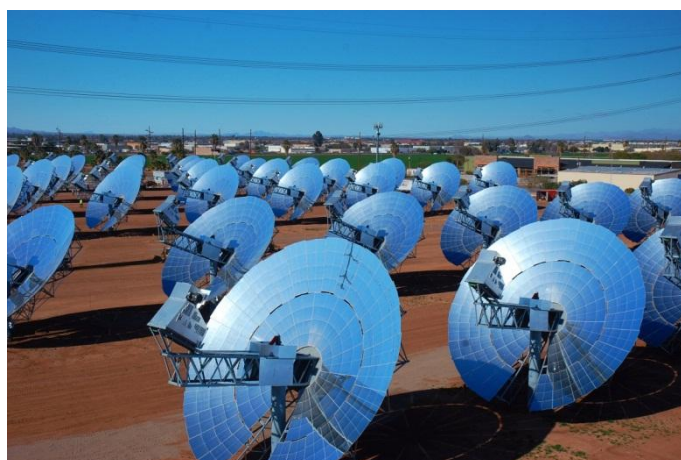
Slika 8. : STE sa paraboličnim tanjurem
