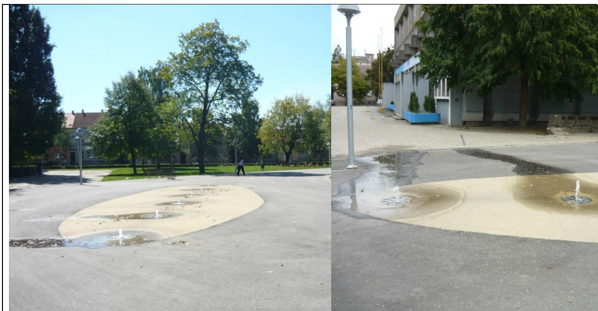
Sl.12) Fontana u sklopu pješačke staze u parku Zrinjevac
