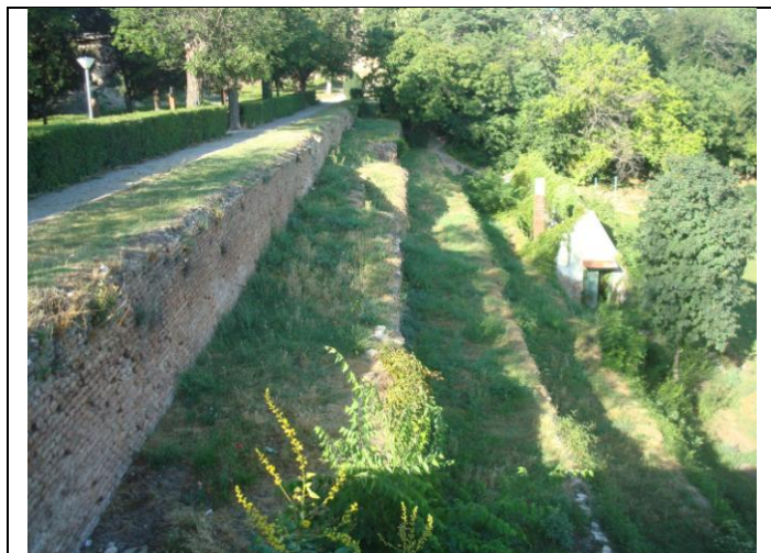
Sl. 14) Podzidane terase
