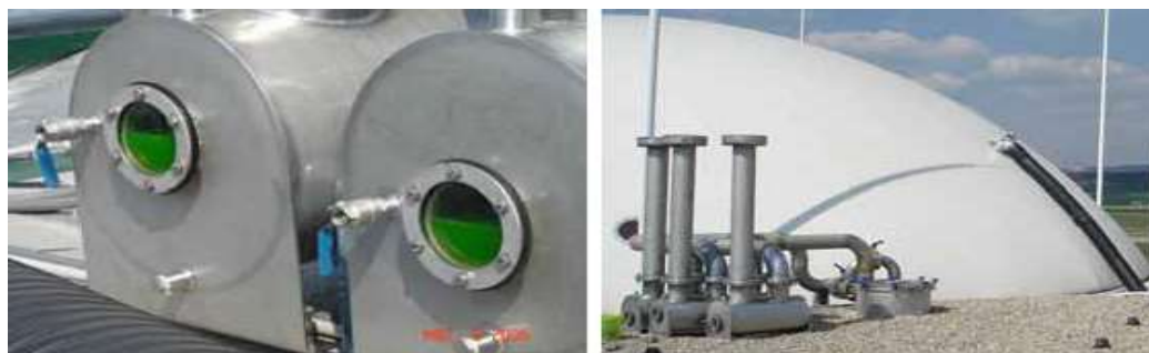
Slika 1. sigurnosni tlačni objekti i ventili (Foto: Agrinz, 2006.)
