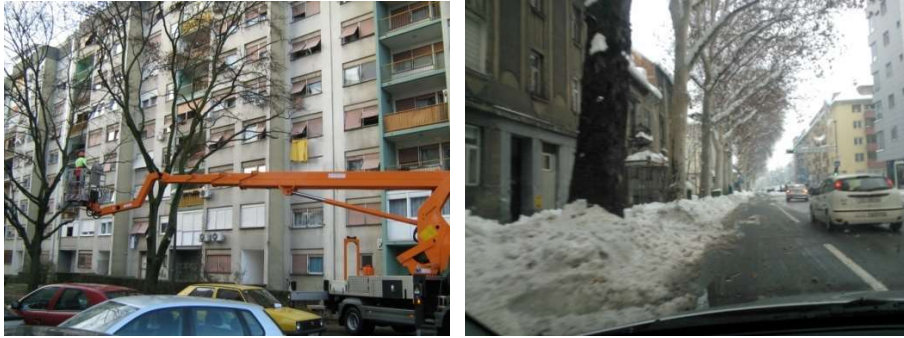
Slika 22. i 23.: Prikaz osiguravanja slobodnog profila oko zgrade i na prometnicama
