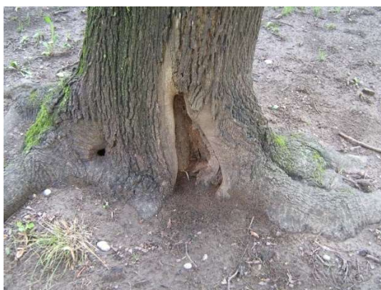
Slika 14.: Prikaz oštećenja korijena
