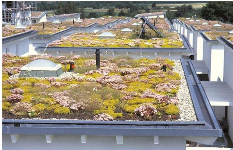
**Slika 5:** Ekstenzivni krovni vrtovi (<http://www.constructa-promet.hr/bauder-zeleni-krovovi>)
