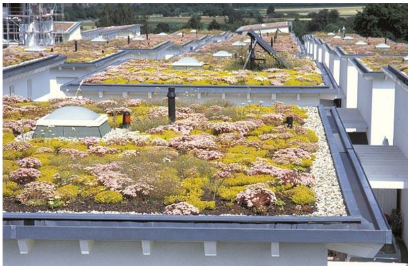
Slika 5: Ekstenzivni krovni vrtovi ( http://www.constructa-promet.hr/bauder-zeleni-krovovi )
