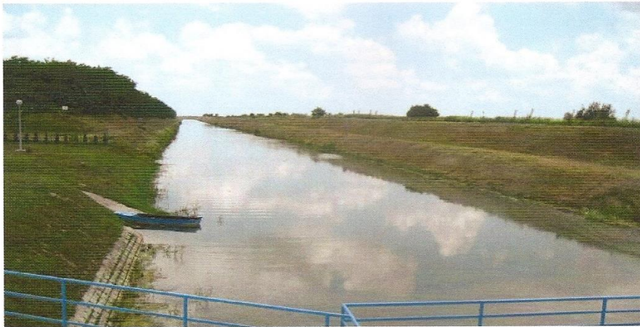
CS Dvor - dovodni kanal
