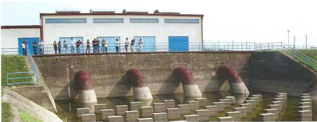
CS Dvor - nizvodno (nakon obnove)
