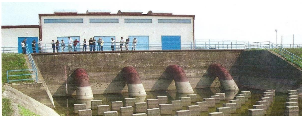
CS Dvor - nizvodno (nakon obnove)
