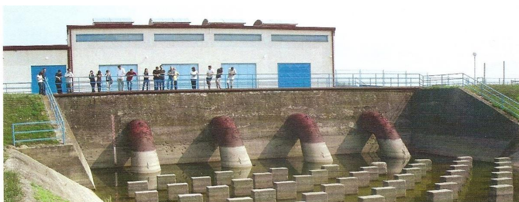
CS Dvor - nizvodno (nakon obnove)
