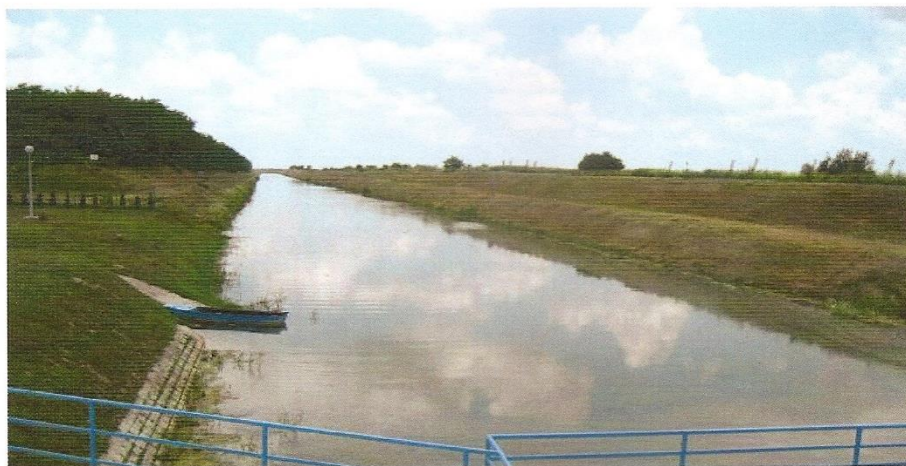
CS Dvor - dovodni kanal
