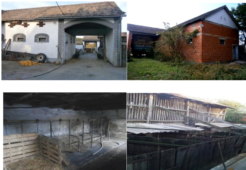
Slika 2. Smještajni objekti na gospodarstvu
