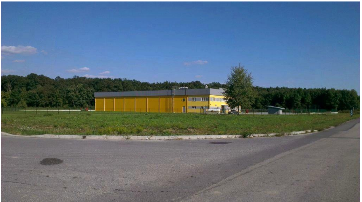
Slika 1. Zgrada Distributivnog centra za voće i povrće d.o.o.
