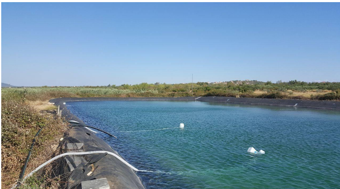
Slika 16. Akumulacijski bazen sa sustavom napajanja
